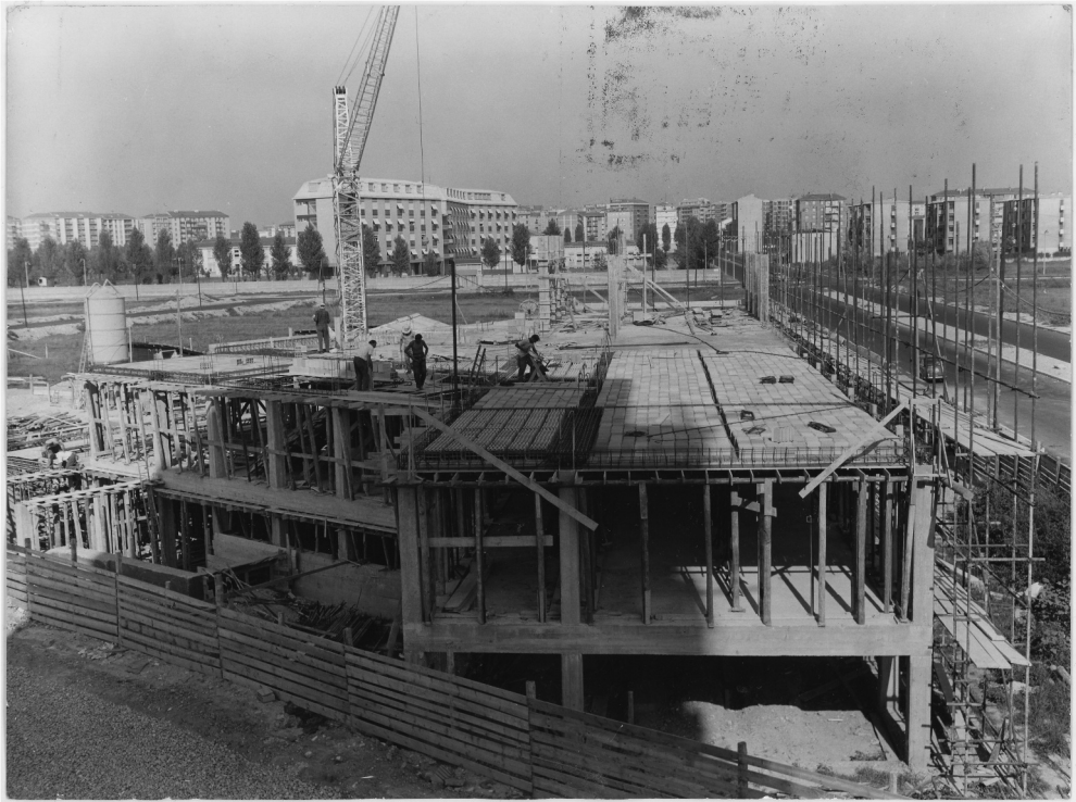
Figure 2. Animated view of the construction site of the new Jewish school in via Sally Mayer, Milan, 1960 (inv. 133-s102-007). Fondo fotografico Bollettino della comunità ebraica di Milano (n.133), Archivio storico della Fondazione CDEC, Milan.
