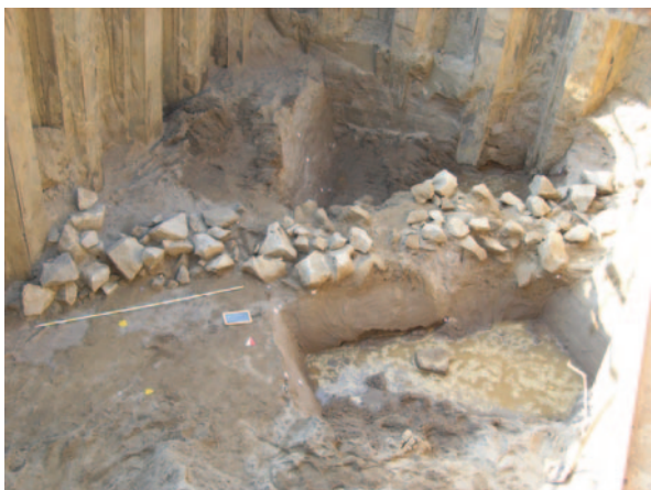
Fig. 3. Este, via Comuna, V52-V53, saggio F: massicciata in blocchi di trachite (Archivio Sabap Ve-Met).
