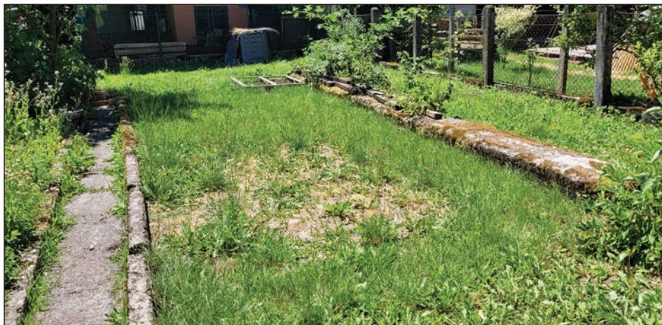
Slika 3: Vidni temelji, ki so bili le delno pozidani in se držijo ene izmed hiš v naselju (Foto: Urška Lampe, 2021).
