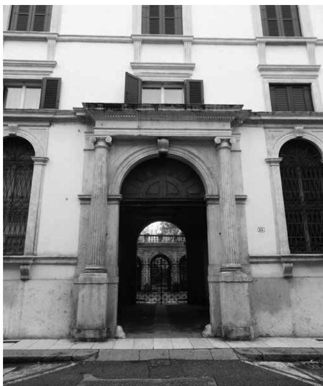
Figg. 8-9. Verona, Palazzo della Torre-Lebrecht-Ederle, facciata su stradone San Fermo e portale di ingresso.
