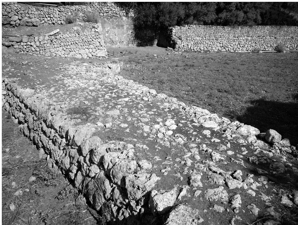
Figura 5. Fortin transitable con vehículos agrícolas en el tramo medio del Barranco de Es Canutells (modelo d.1 bis) (foto: L. Bonardi, 2010).
