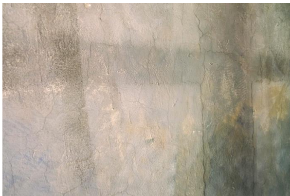
Fig. 7. Scurimenti superficiali in corrispondenza delle travi e pilastri in calcestruzzo. Fig. 8. Sollevamenti e sali sulla superficie.
