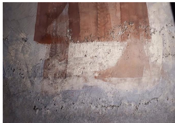
Fig. 7. Scurimenti superficiali in corrispondenza delle travi e pilastri in calcestruzzo. Fig. 8. Sollevamenti e sali sulla superficie.
