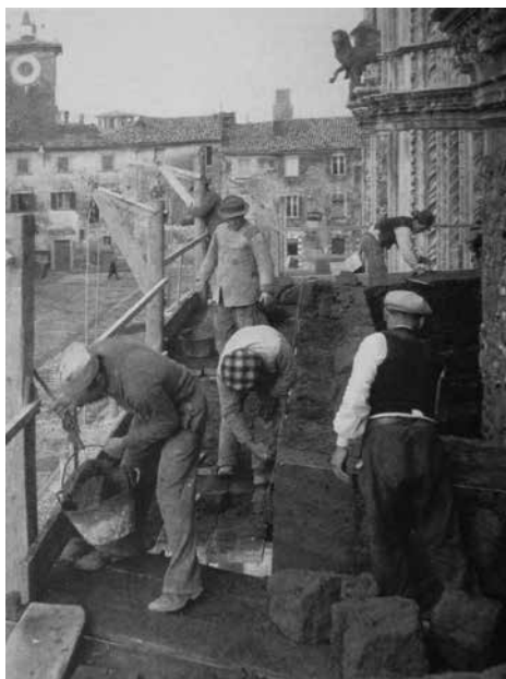
In alto: 8. Orvieto, blindaggio della parte basamentale della facciata del Duomo
