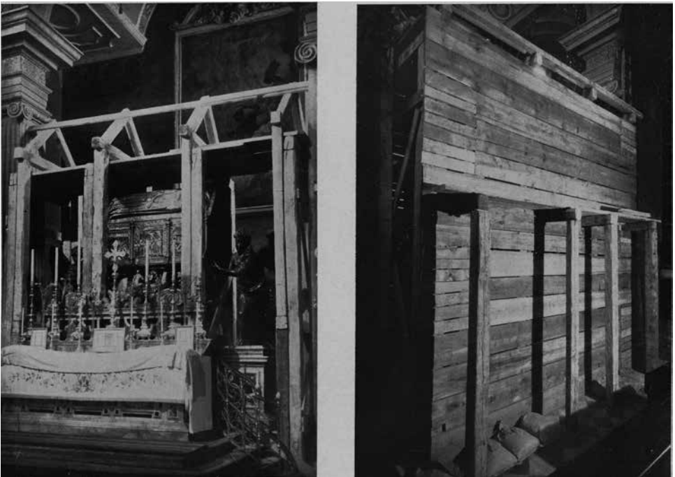
2. Zara, Arca di San Simeone, protezione antiaerea, pubblicata in La protezione del patrimonio artistico nazionale dalle offese della guerra aerea , a cura della Direzione Generale delle Arti, Firenze, Le Monnier, p. 264
