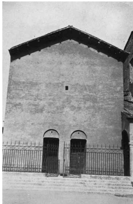
4. Perugia, blindamento della facciata di S. Bernardino, pubblicata in La protezione del patrimonio artistico nazionale dalle offese della guerra aerea , a cura della Direzione Generale delle Arti, Firenze, Le Monnier, p. 266
