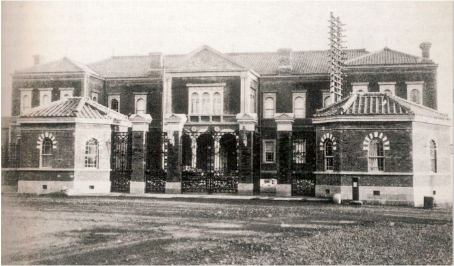
Fig. 9 Sede Centrale delle Telecomunicazioni
