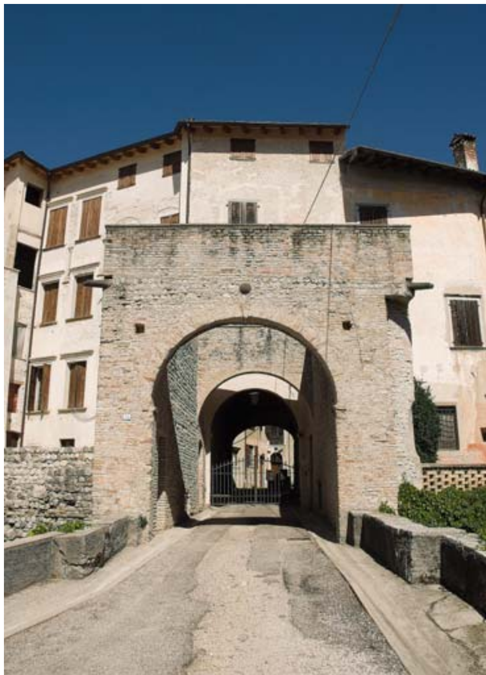
Veduta dell'ingresso fortificato del castello di Valvasone.
