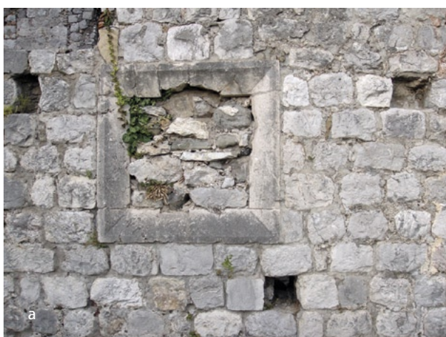
fig. 4.15a – Apertura quadrangolare tamponata, Stari Bar (n. 136).
