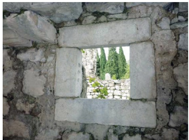
fig. 2.22 – UTCF 145b ingresso e finestra sul lato sud.
