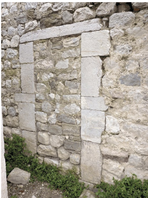
fig. 2.7 – Ea 55114, apertura, poi tamponata, attraverso la quale si accedeva all'UTCF 144.
