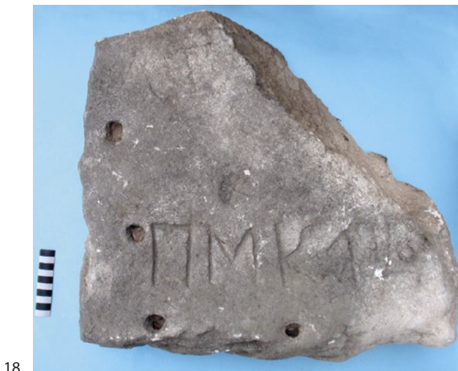
fig. 4.4d – Alloggi di staffe e perni per assemblaggio e posa in opera.
