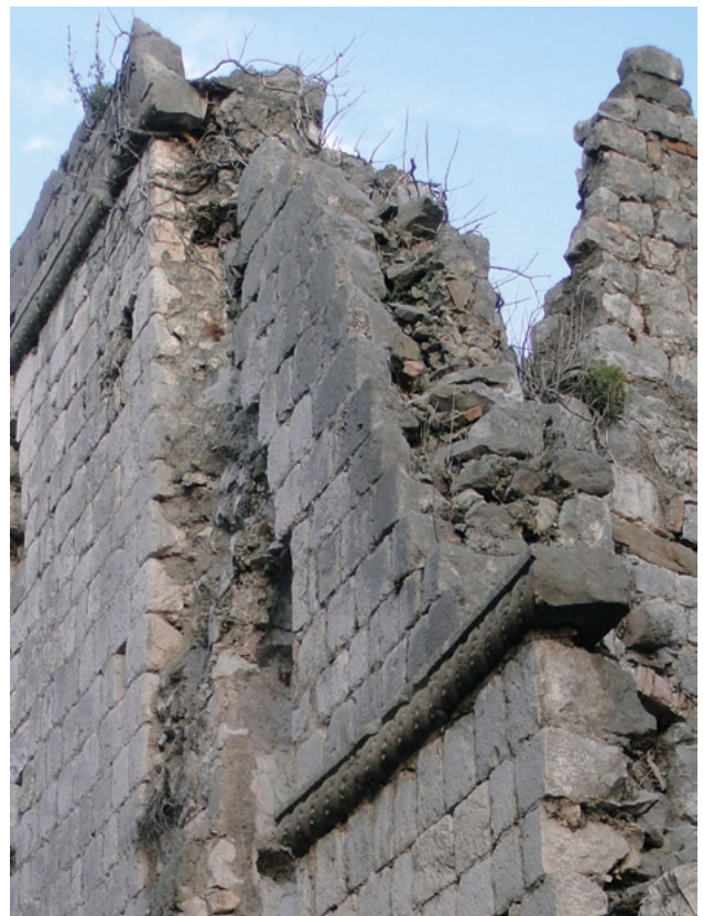
fig. 4.26a-b – Cornici marcapiano in opera nel cd. Palazzo del Doge (n. 136), Stari Bar.
