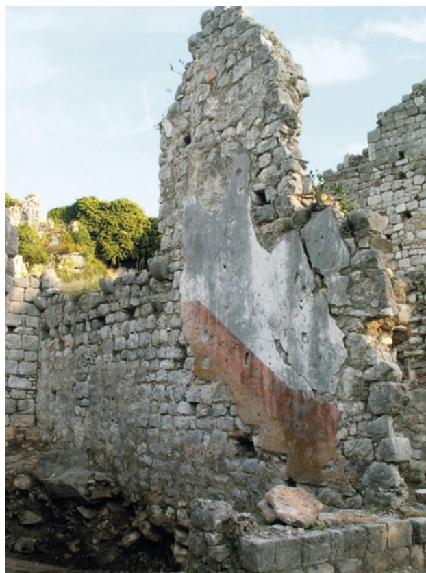
fig. 2.12 – PPS 146: indicatori della presenza di una scala lignea.
