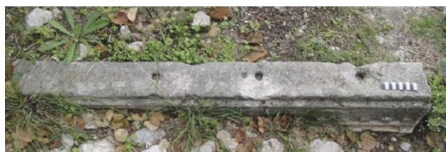
fig. 4.23 – Elemento orizzontale (architrave) di finestra con motivo decorativo a dentelli reimpiegato in funzione di soglia, Stari Bar (n. 6).
