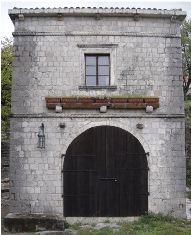
fig. 4.25 – Cornici marcapiano reimpiegate nel rifacimento dell'edificio adibito a museo, Stari Bar (n.147).
