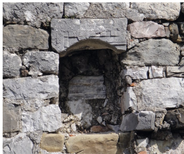
fig. 4.24a – Cornice con motivo decorativo a dentelli reimpiegata in funzione di architrave in scansia di fase turca, Stari Bar (n. 19).
