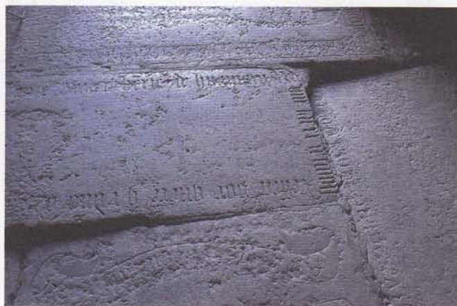
Fig. 3. Détail du dallage du vestibule montrant l'état de conservation de certaines plates-tombes : au centre dalle n° 5, à droite dalle n° 1, devant dalle n° 6 et à l'arrière plan dalle n° 2. Cliché R. Le Penec, 1999
