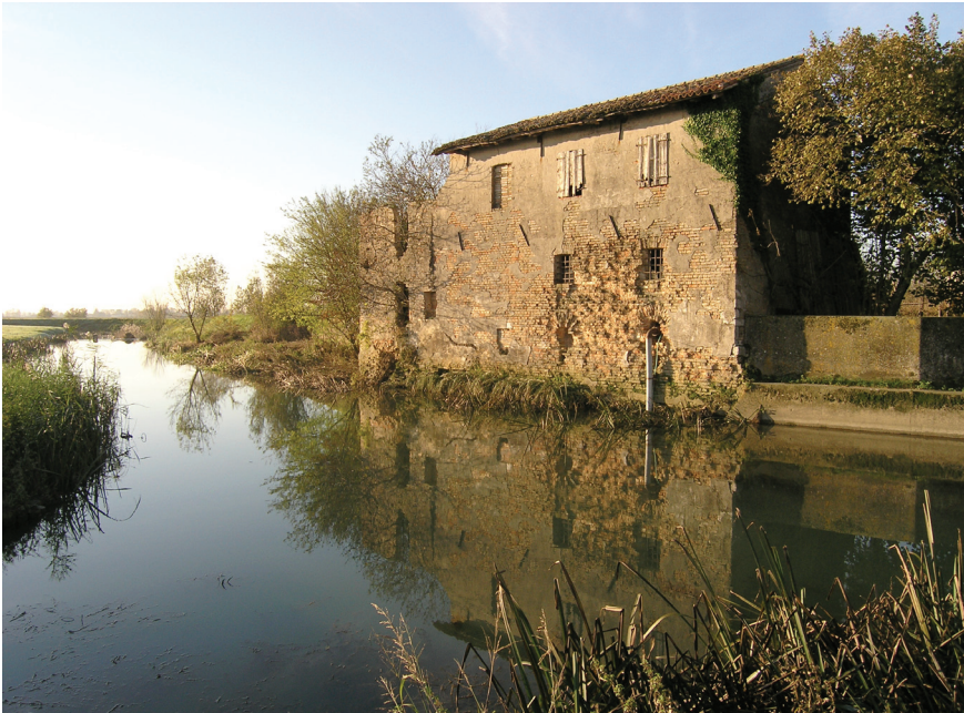
Imatge 3. Les noves estratègies de recuperació ambiental i paisatgística han de partir de la recuperació del patrimoni construït, com és el cas dels molins abandonats en els cursos d'aigua menors.
