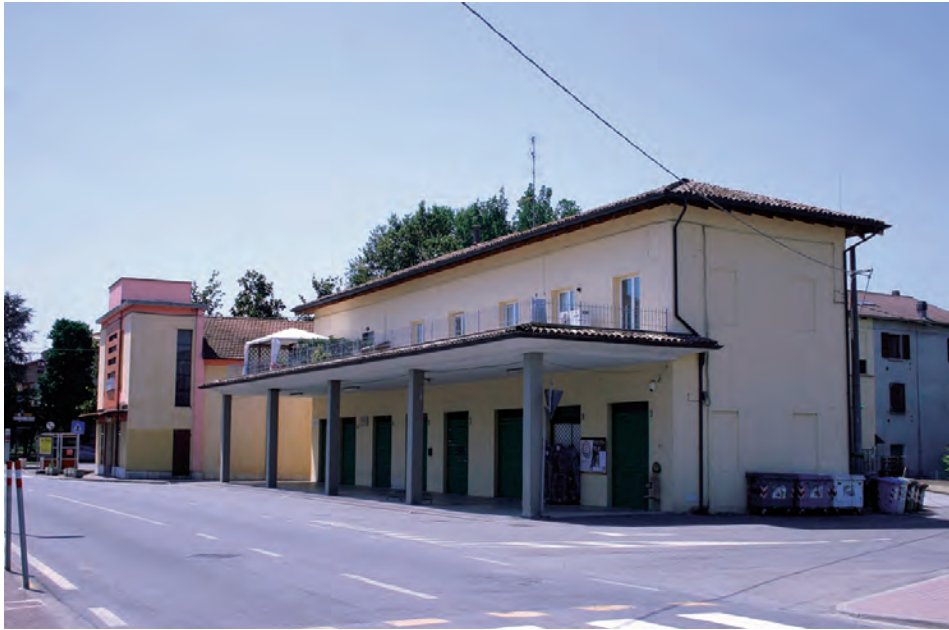
Massenzatico oggi: in primo piano l'edificio che ospitava la Cooperativa di consumo e sullo sfondo il Teatro Artigiano (foto Enrico Morosini e Emily Corradini - luglio 2011)
