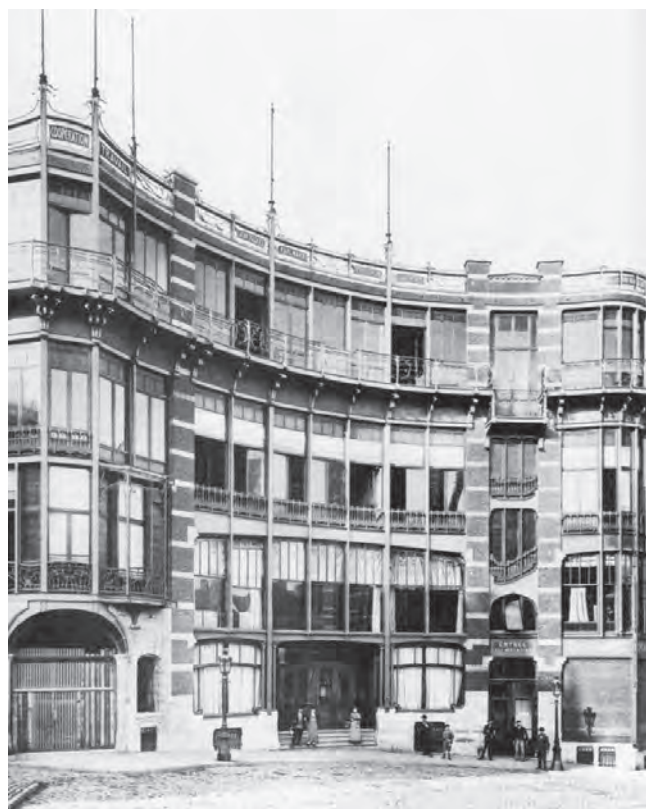
La facciata principale (foto d'epoca) (J. Delhay, La Maison du Peuple de Victor Horta , Atelier Vokaer, Bruxelles 1987)
