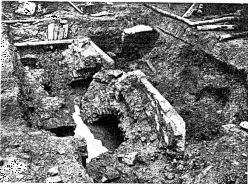
La copertura a volte del rio Batario rinvenuta nel corso degli scavi in piazza S. Marco (1888-89) (da F. BERCHET, Relazione degli scavi in piazza S. Marco , op. cit.).
