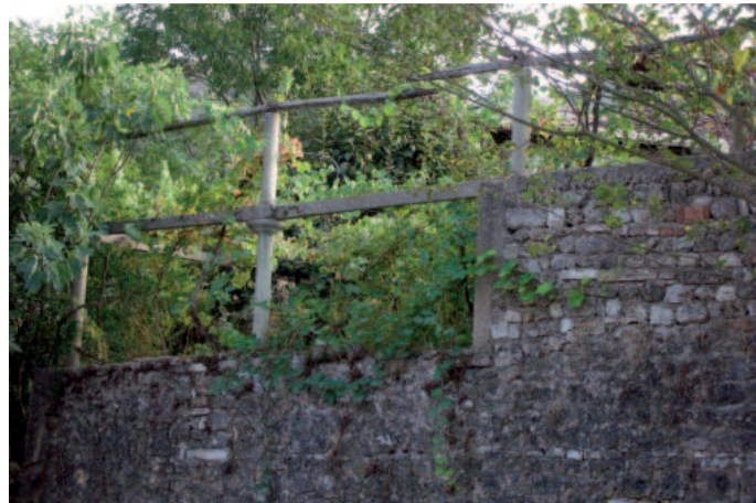
DALL'ALTO: FORTEZZA (KALA) PENTAGONALE DI DELVINA. IN PRIMO PIANO SULLA DESTRA LA MOSCHEA HÜNKÂR ("IMPERIALE"); DELVINA, PAESAGGIO; DELVINA, MURO DI CINTA DI UN GIARDINO
