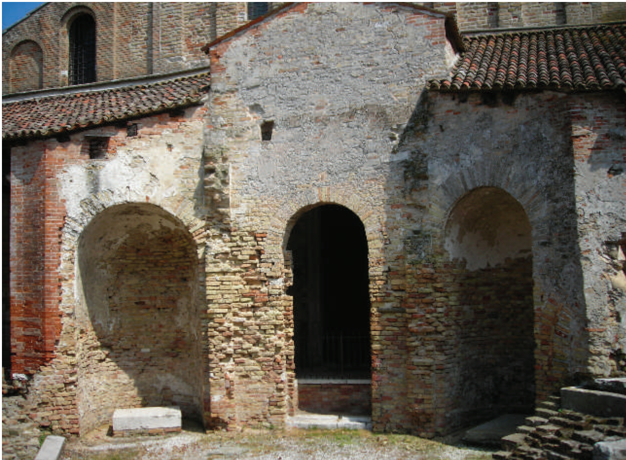
Fig. 19. Torcello, resti del battistero con due nicchie absidate e al centro la porta rivolta verso il portico di Santa Maria Assunta, si noti il livello della soglia inferiore al pavimento del portico (0.70 m di differenza) (foto Agazzi)
