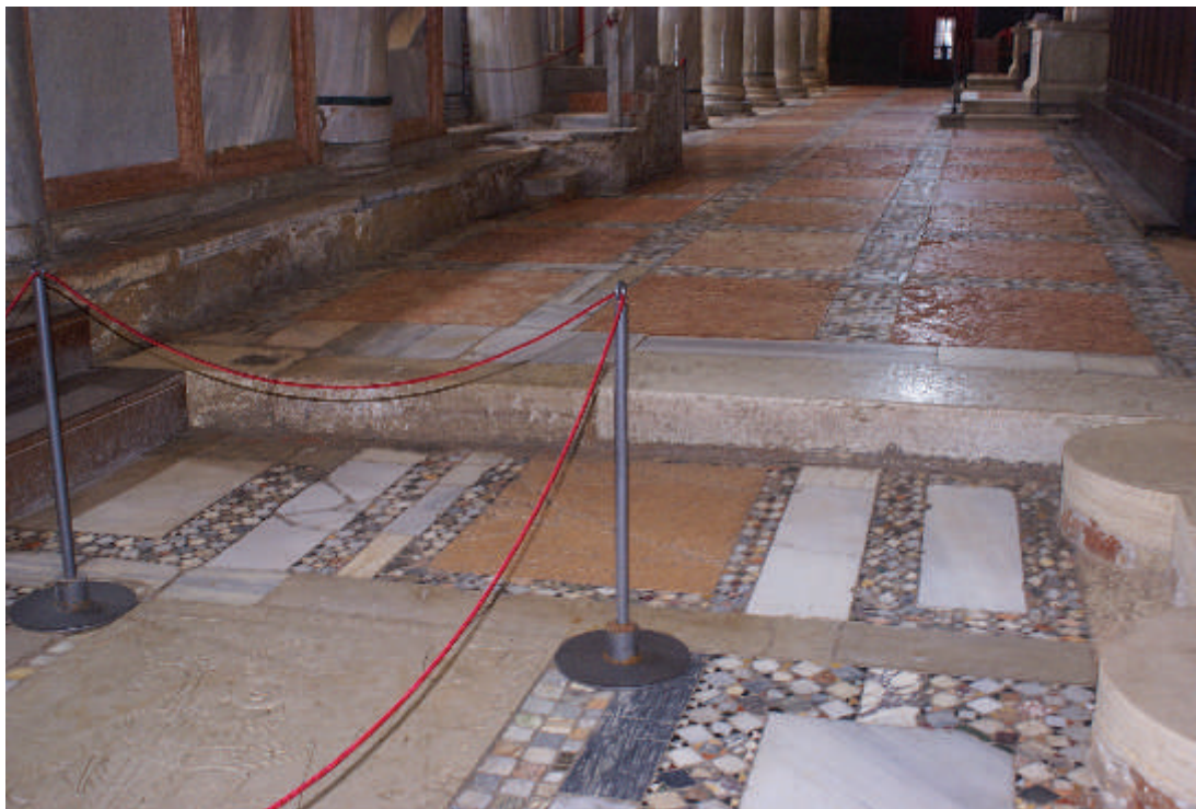
Fig. 18. Torcello, Santa Maria Assunta, dislivello tra la cappella absidale settentrionale e il pavimento di navata (foto Agazzi)
