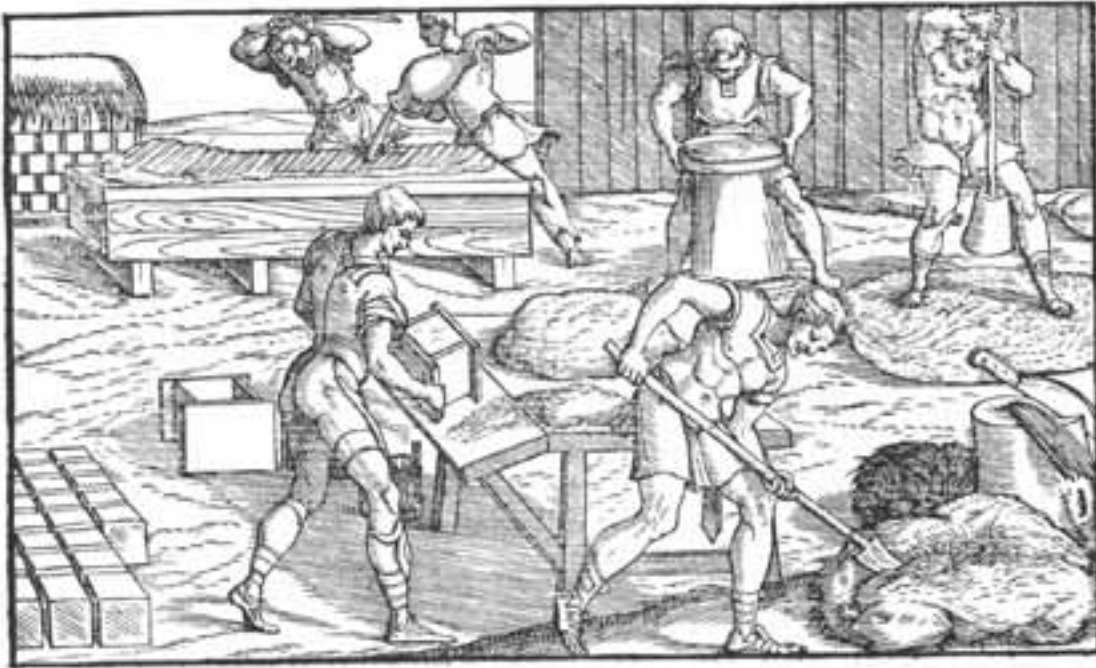
Muratori intenti a preparare mattoni da costruzione, da G.A. Rusconi, Dell'architettura , Venezia 1590, Libro II, p. 32.
