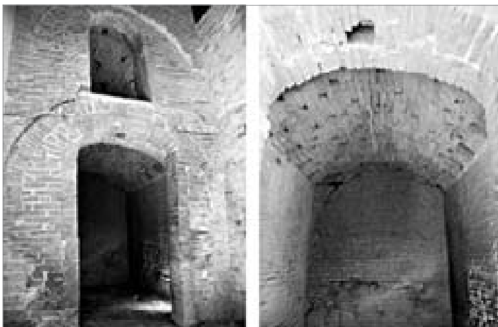
fig. 12 – Esterno ed interno della seconda fornace aggiunta al complesso Coccapani a Calcinaia (Area 4000, secondo quarto del XIX secolo).
