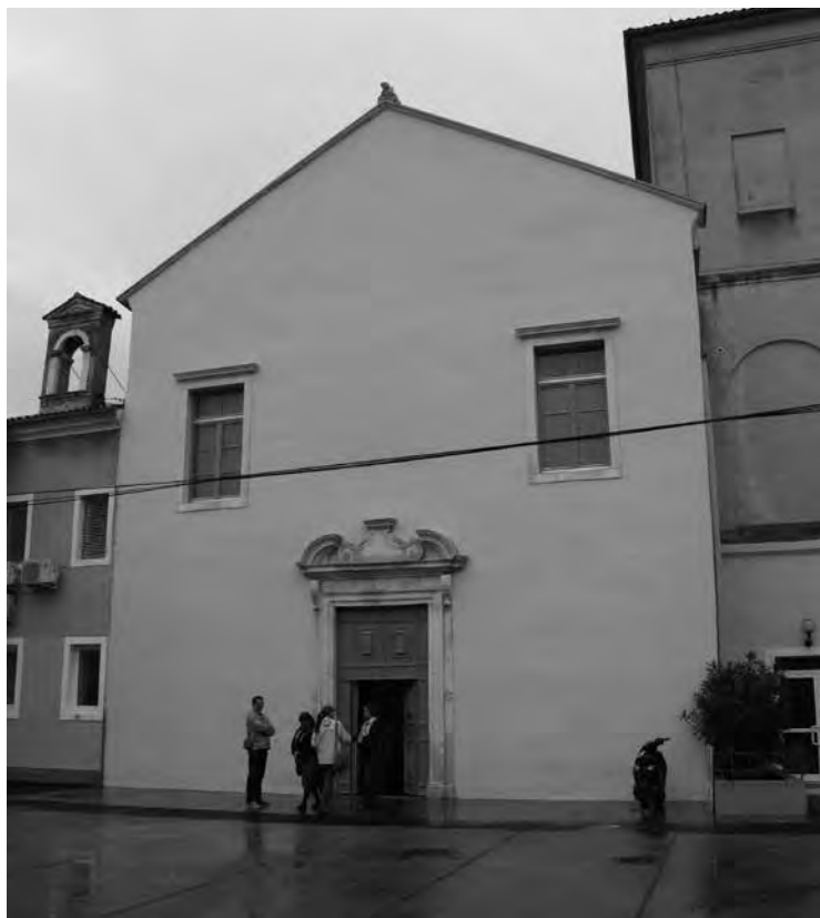
Fig. 3 – Facciata della chiesa dopo l'ultimo restauro.
