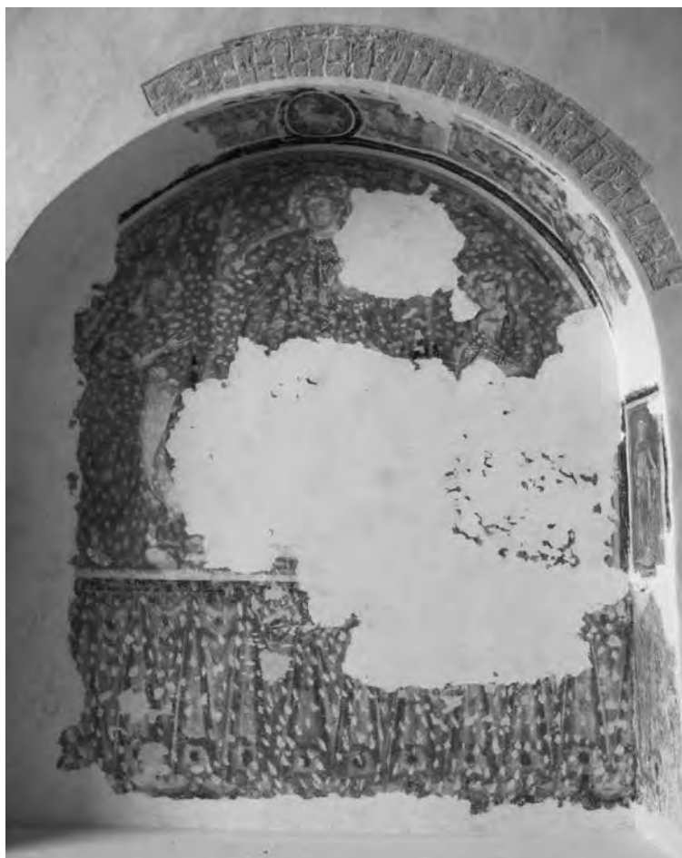
Fig. 7 – Una delle nicchie affrescate della chiesa attualmente molto danneggiata.
