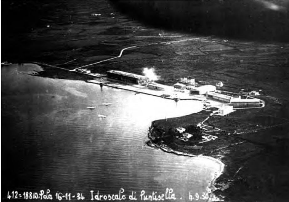
Fig. 11 - Veduta aerea dell'idroscalo di Puntisella (senza il porto di Valbandon) nel 1934.
