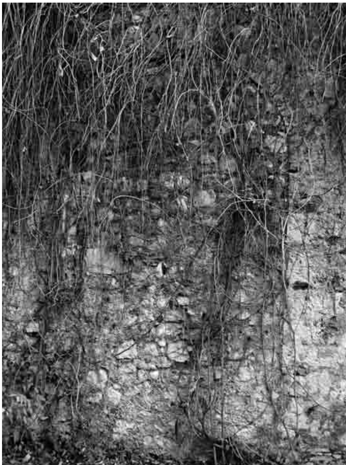
VILLA DELLA TORRE A MEZZANE: NEL MURO CHE RACCORDA IL DISLIVELLO DEI DUE GIARDINI SI TROVANO TRE APERTURE ARCUATE, QUELLA CENTRALE ORA TRASFORMATA IN NICCHIA, LE LATERALI TAMPONATE
