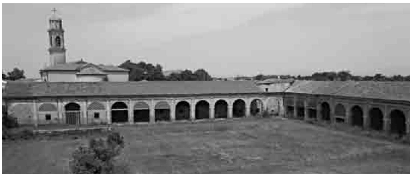
IN ALTO: PROSPETTO DELLA BARCHESSA SULLA VIA COMUNE IN BASSO: CORTE GRANDE DELLA CUCCA, VEDUTA
