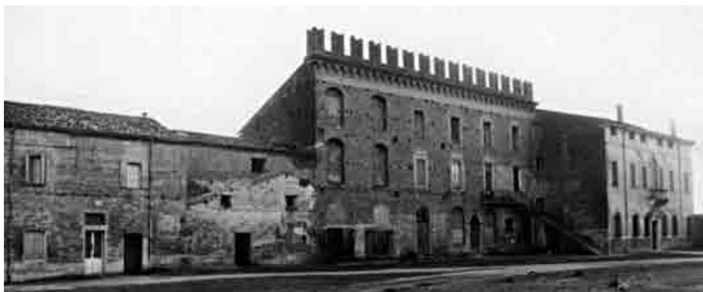
IN ALTO: SCORCIO DELLA BARCHESSA DELLA CUCCA IN BASSO: L'ANTICO FORTILIZIO E A DESTRA LA VILLA RISTRUTTURATA DAI SEREGO NEL 1775
