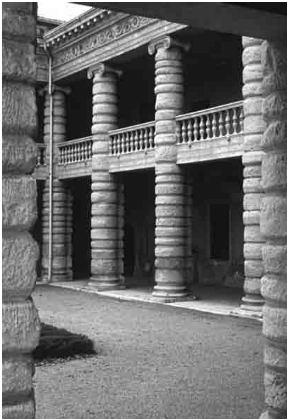
VILLA SEREGO A SANTA SOFIA: LOGGIA CON COLONNE BUGNATE (FOTO ARCHIVIO CDSV)
