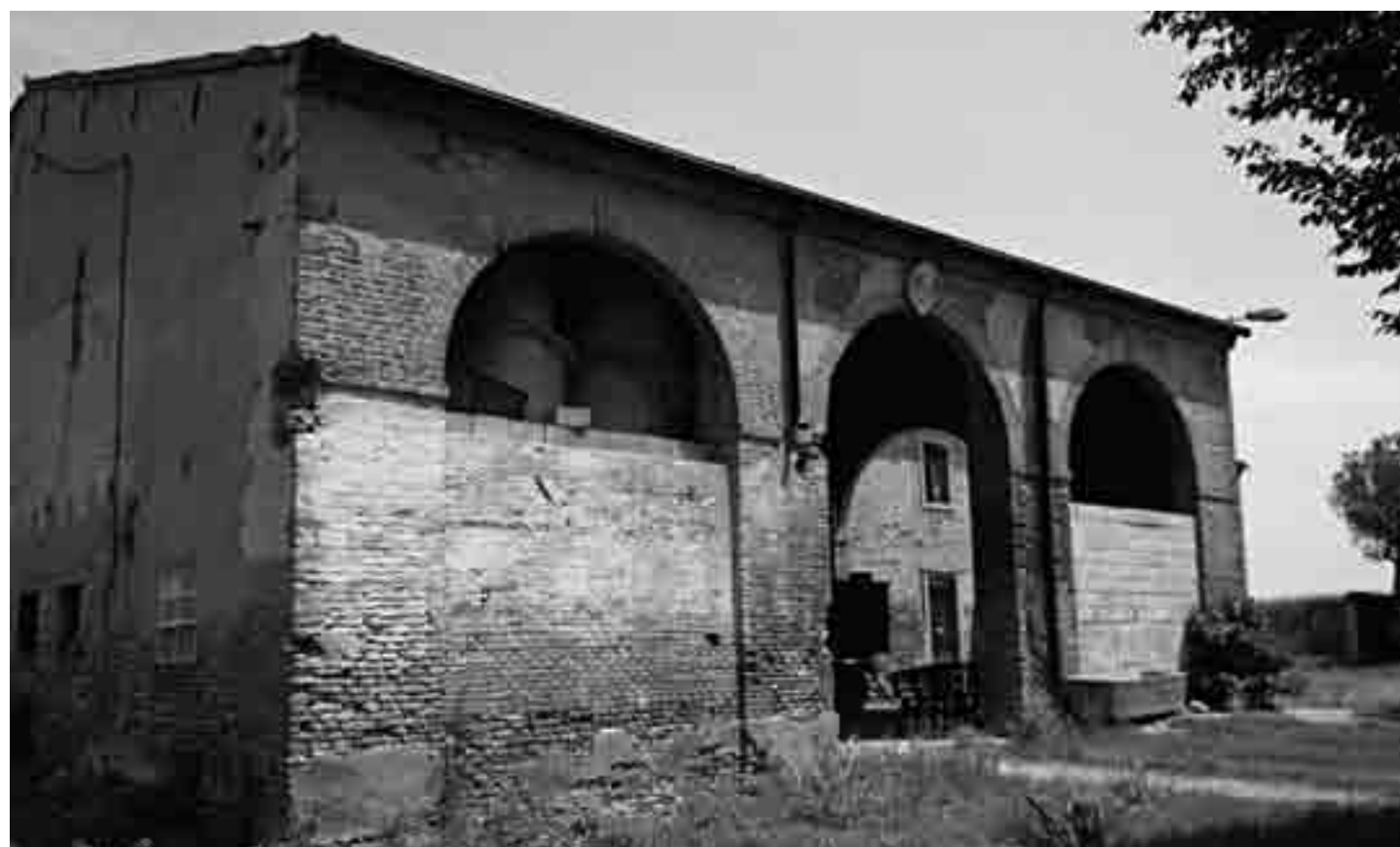
IN ALTO: PALAZZETTO SEREGO NELL'ANTICA VERONELLA (OGGI OPPI), VEDUTA D'INSIEME IN BASSO: BARCHESSA DI VERONELLA ANNESSA AL PALAZZETTO
