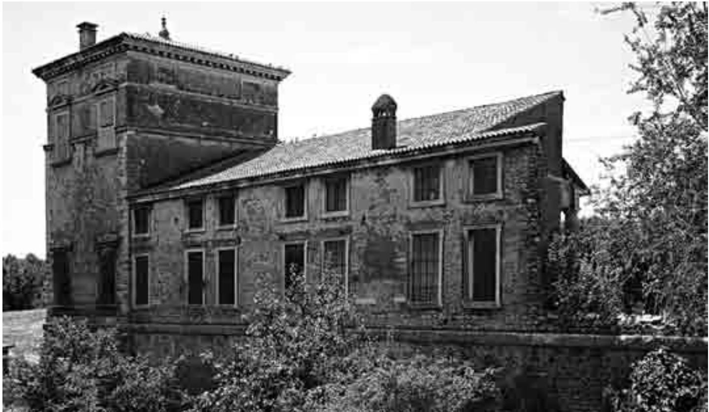
Villa Trissino a Meledo, frammento della barchessa e della colombara nello stato precedente al restauro in corso.
