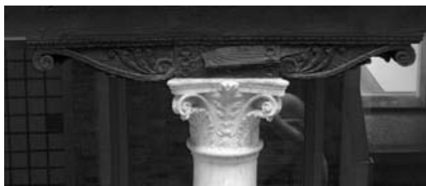
Fig. 4. Ca' Giustinian dei Vescovi, corte minore: la colonna posta al centro del passaggio dall'atrio alla corte regge un elegantissimo architrave ligneo intagliato con mensole a barbacane di disegno anticheggiante.
