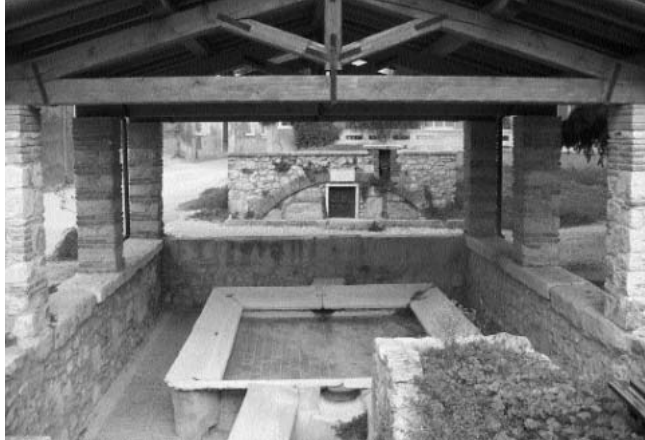
Fontana e lavatoio di Pedemonte.
