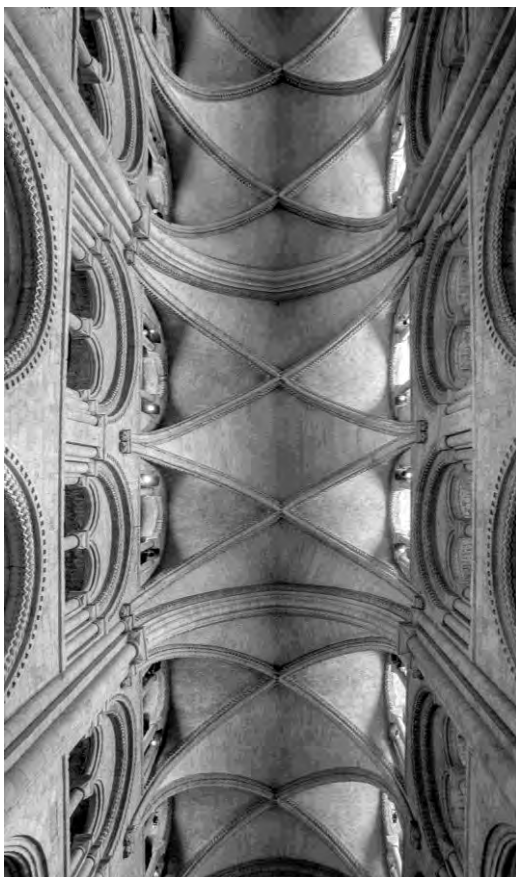
Fig. 3: Durham, cattedrale. Arcate delle navate, bifore delle gallerie, cleristorio e volte costolonate delle coperture.
