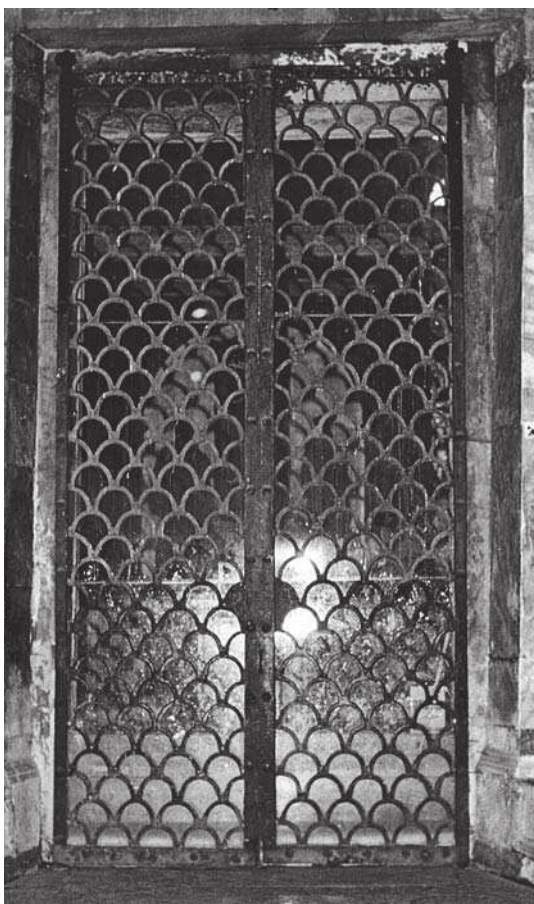
4. Battenti a traforo della Porta da Mar. Venezia, basilica di San Marco.
