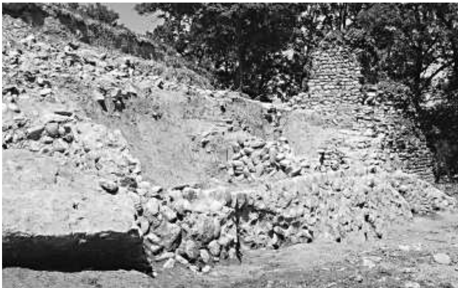
Fig. 18 - Marano sul Panaro. Castello. In primo piano muro di cinta crollato.
