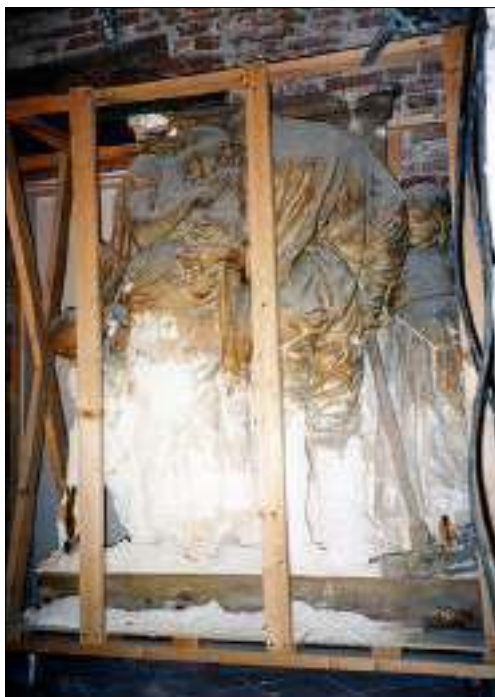
Figura 5. Jules Van Biesbroeck, Ai nostri morti , prima dell'intervento di restauro. Si nota il gesso eroso nella parte inferiore, in alcuni casi, fino a mostrare la struttura interna in ferro. AGIAMVe
