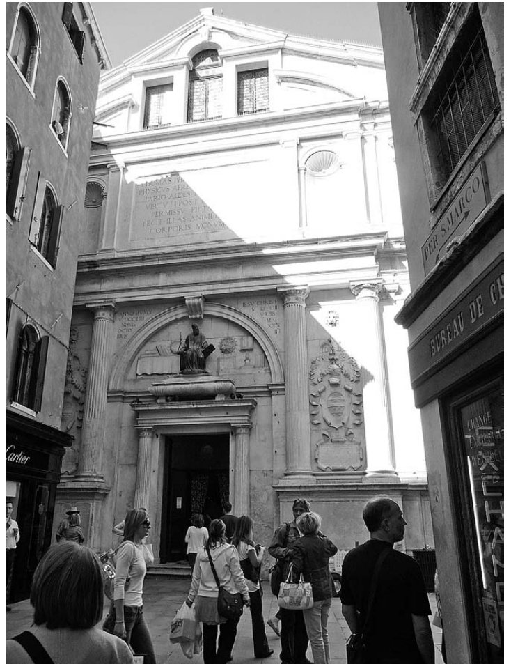
Fig. 1 – Venise, église San Zulian, façade.
