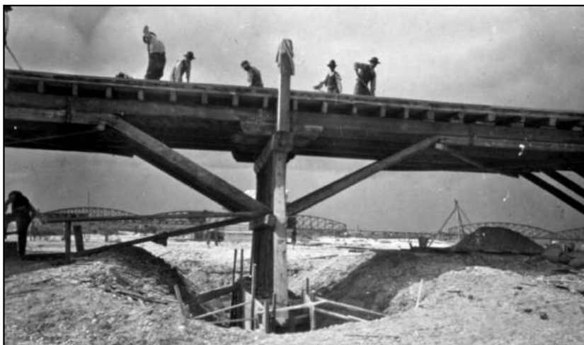
FIG. 8. Costruzione del ponte di Pieris sull'Isonzo.
