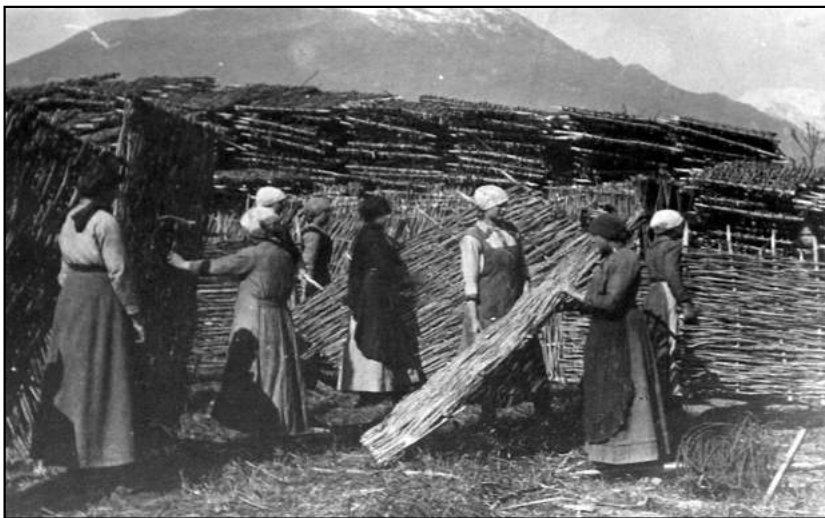
FIG. 6. Allestimento di graticci per trincee a Campo Rossignolo, Altipiano di Asiago. Fonte: Museo della Guerra di Canove-Roana.
