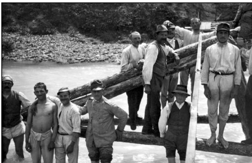
FIG. 9. Operai durante la costruzione di un ponte. Località non specificata.
