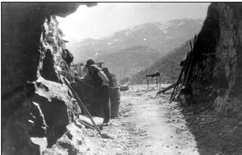
FIG. 3. Scavo di una galleria sul monte Paù. Fonte: Museo della Guerra di Canove-Roana.
