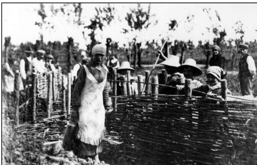
FIG. 13. Costruzione di rivestimenti di trincee presso Treviso nel 1918. Fonte: Museo del Risorgimento, Roma, Album, A-IV, foto n. 4571.
