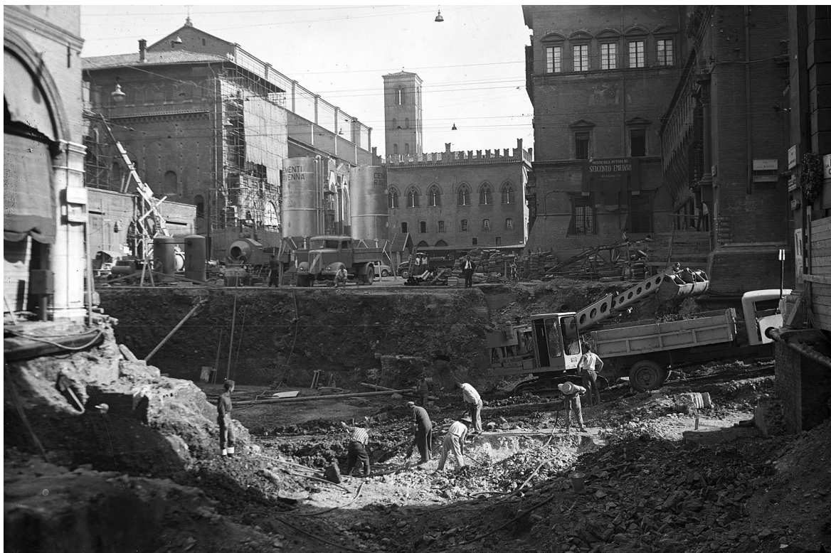
1. Bologna (1959), incrocio tra Via Indipendenza e Via Ugo Bassi-Piazza del Nettuno. Lavori di sbancamento per la realizzazione del sottopasso (Archivio SABAP BO-MO-RE-FE neg. 13550)
