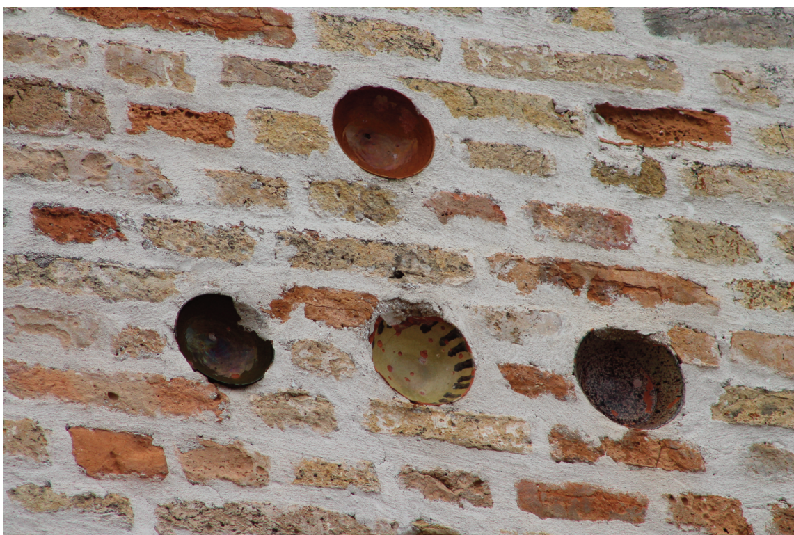
Fig. 13. Particolare dei "bacini" disposti a croce sulla chiesa di Sant'Agostino a Torre di Palme. Foto S. Gelichi
