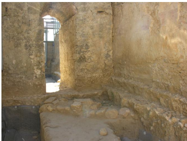
Fig. 5. Muro della "villa rustica" tagliato dalla costruzione della Basilica e dei suoi contrafforti (foto E. Gasparini).
