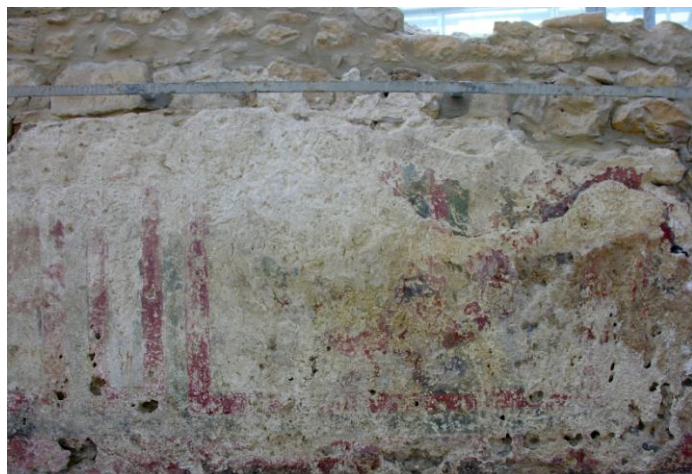
Fig. 19. Particolare delle due fasi di pitture sovrapposte presso l'ambulacro meridionale del Peristilio (foto: E. Gasparini).
