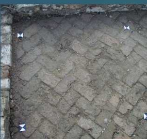
USM 1044, area dell'ospizio, pavimento in laterizi detti “altinella” in opus spicatum.
