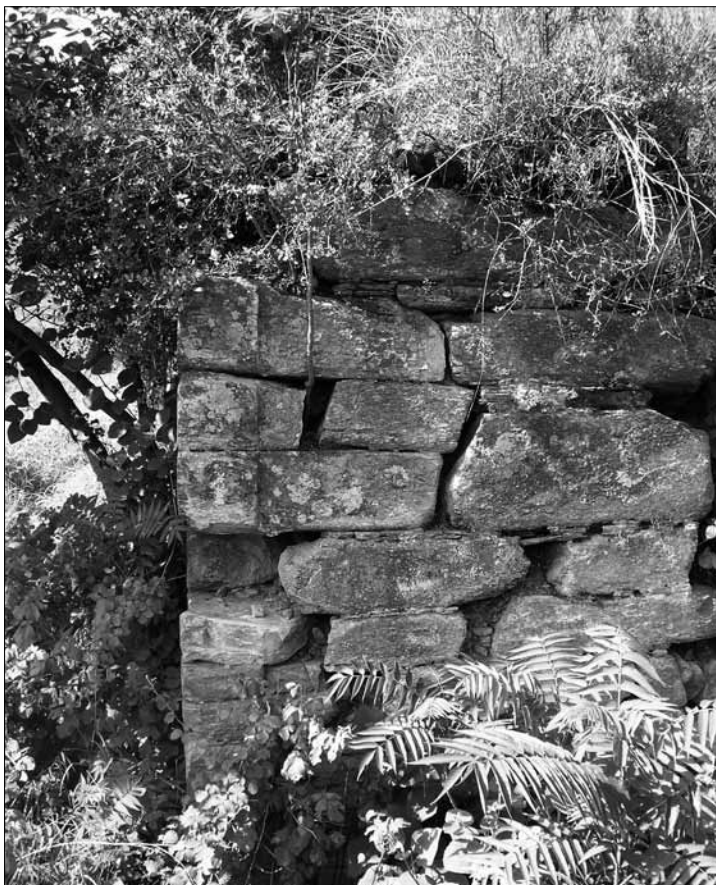
Fig. 29. Stupa of Jurjurai. 1 st storey, detail. (Spagnesi 2005).
