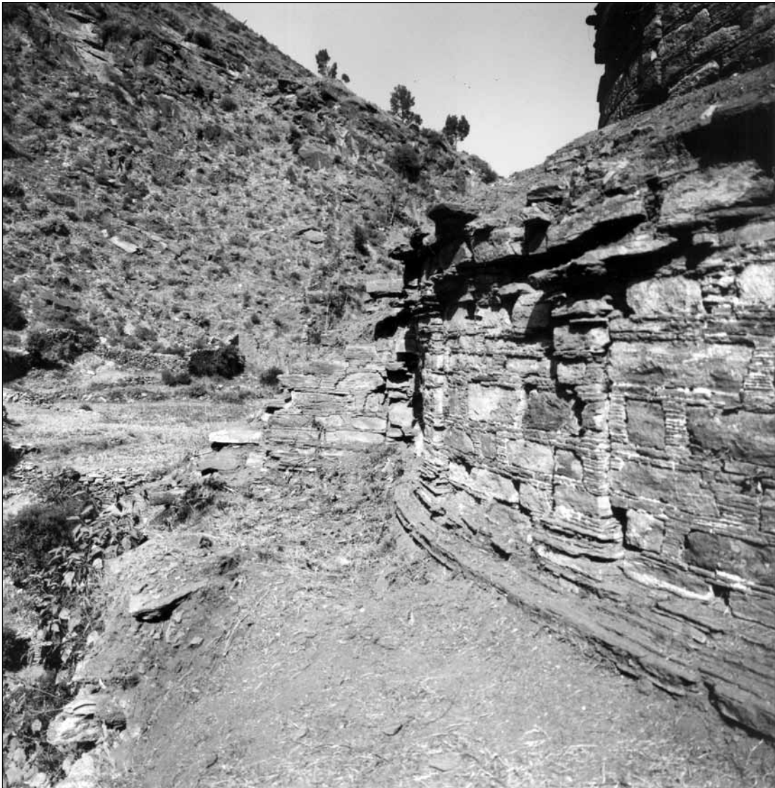
Fig. 236. Abbasahchina. Stupa A. S side, 2 nd storey. (Kuwayama 1993).
