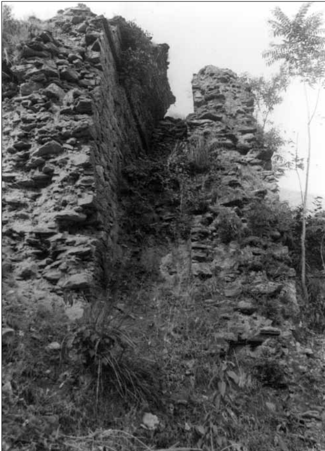
Fig. 334. Tokar Dara (Najigram). Aqueduct. (Nascari 1993).
