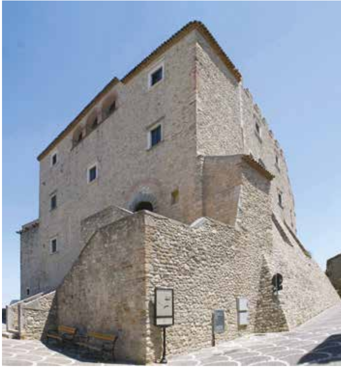
III. Angolo nord-ovest del Castello.
