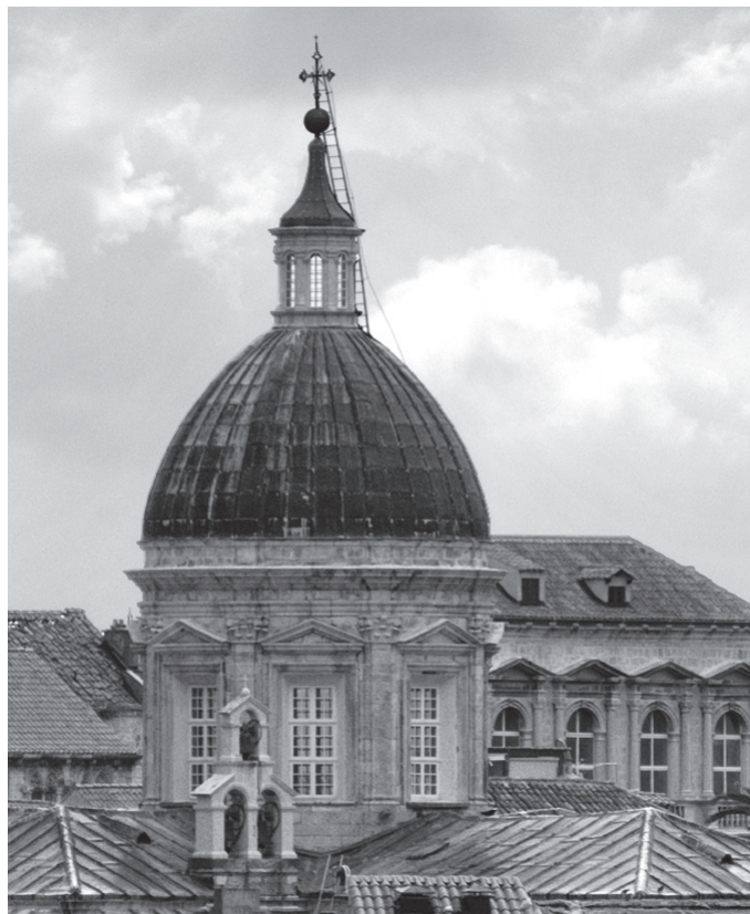
23. Dubrovnik, cattedrale, estradosso della cupola (Foto G. Bonaccorso)
